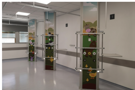
Groote Schuur Hospital - Western Cape
